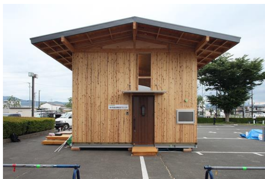
新部室と同じ構造外壁現し事例
